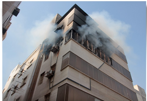
اطفاء حریق آپارتمان ۱۴۰۰/۷/۲۷
