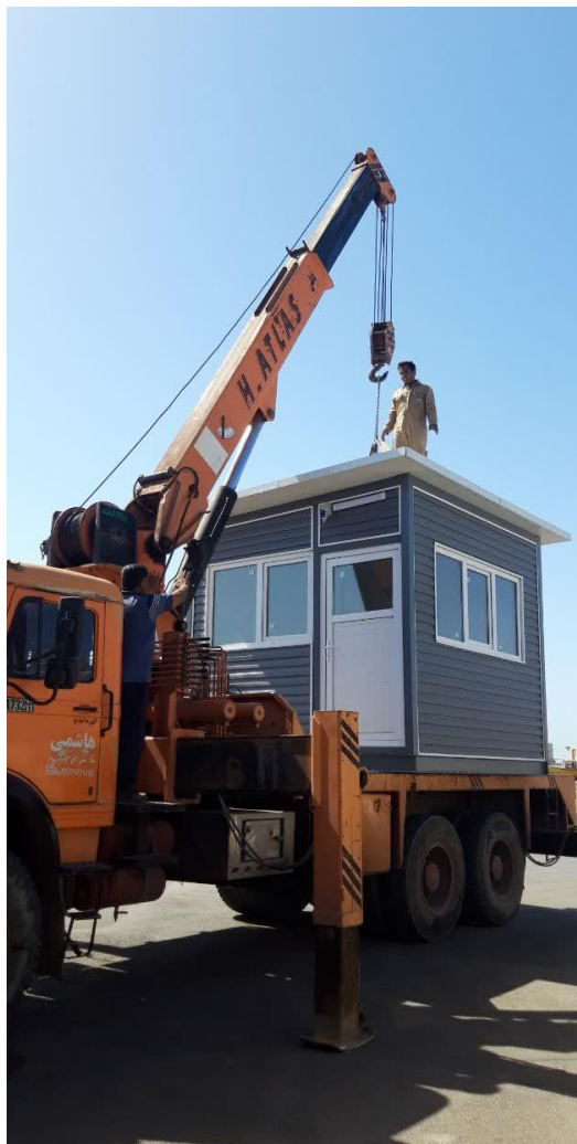
نصب کانکس نگهبانی ایستگاه ۸
