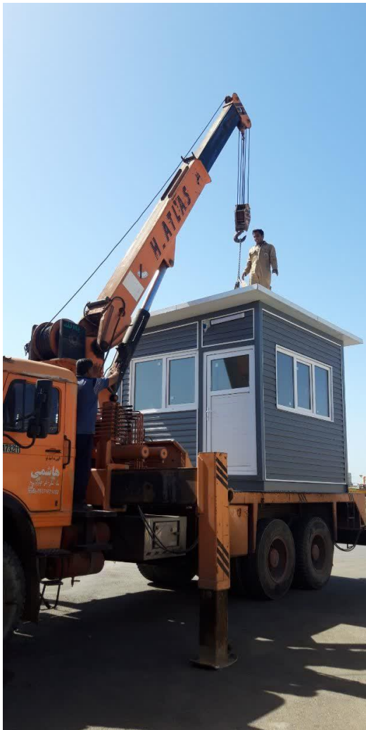
نصب کانکس نگهبانی ایستگاه ۸
