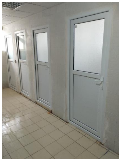
تعویض درب سرویس های بهداشتی ایستگاه شماره ۱۰ و مرکز آموزش
