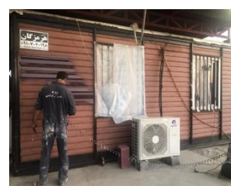
رنگ آمیزی کانکس ایستگاه ۵
