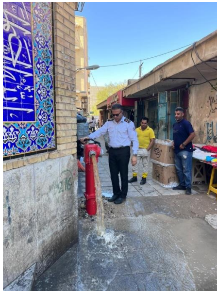
نصب شیر آبگیری خودروهای آتش نشانی (هیدرانت)
