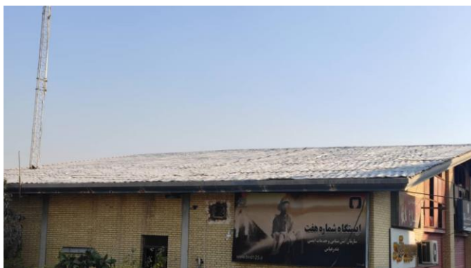
نصب ایزوگام سقف ایستگاه شماره ۷
