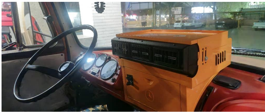
نصب کولر خودرو آتش نشانی ایستگاه شماره ۳
