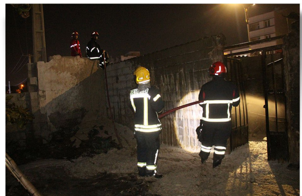
۱۴۰۳/۰۲/۰۲ حریق انبار سوخت
