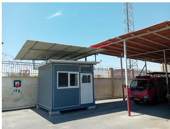
ساخت سایه بان کانکس ریسی ایستگاه شماره ۸
