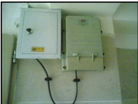
در تصویر رو به رو مشاهده می کنید که یک دستگاه **RU** در یک ساختمان ۸ واحدی نصب شده و یک سیم تک زوجی به ورودی دستگاه وصل و تعداد ۸ خط از این دستگاه خارج شده و به ترمینال ساختمان وصل گردیده است.
