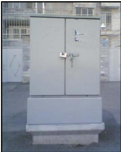
**کافو:** جعبه های بزرگی است که در محله ها نصب می شود و با ورود حداکثر تا یک هزار شماره در آن به یک طرف ترمینال و از طرف دیگر ترمینال به پست ها منتقل می شود.
