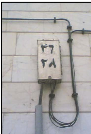
**پست:** جعبه های پلاستیکی یا فلزی کوچکی است که بر روی دیوارها نصب می شود و در داخل آن از ۱۰ الی ۵۰ زوج خط تلفن می باشد. این جعبه در ارتفاع ۱/۸۰ متر نصب می شود. شکل مقابل یک جعبه پست را نشان می دهد.
